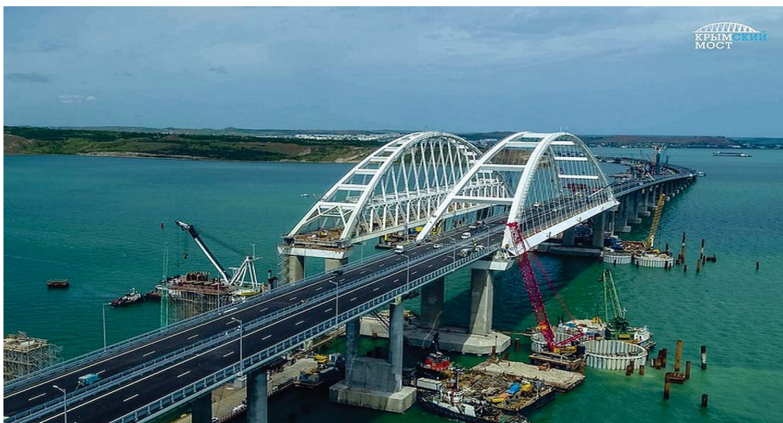
Рис. 1. Уникальное сооружение – мост через Керченский пролив Fig. 1. A unique structure – a bridge across the Kerch Strait
