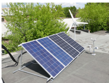
б) Ветро-солнечно-дизельная генерирующая установка 1 кВт
